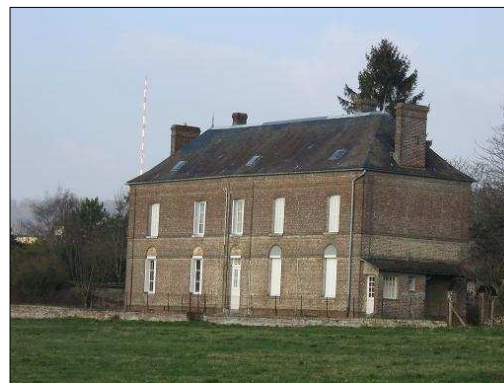
Construction ancienne en briques
