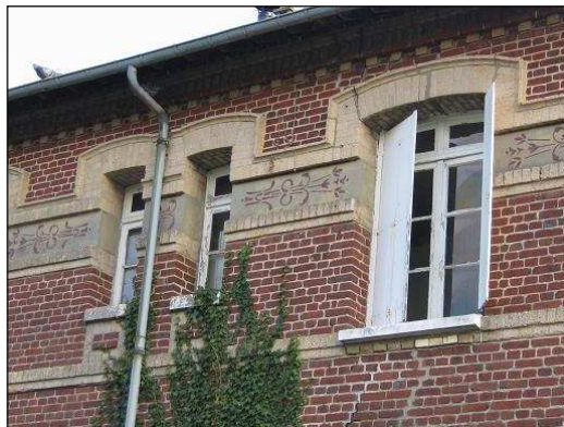
Hauteur des bâtisses
